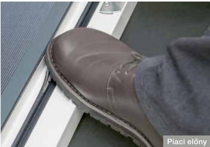
- A középtömítéseket gyakran a keretprofilra ragasztják, és állandó igénybevételnek vannak kitéve – nincs védelem a sérülés vagy kopás ellen.
