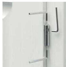
3D állítható pántok beállítása
