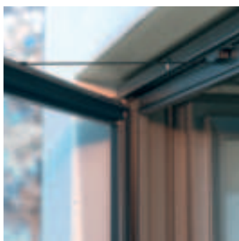
Ajtócsukó, állítható zárási sebességgel
